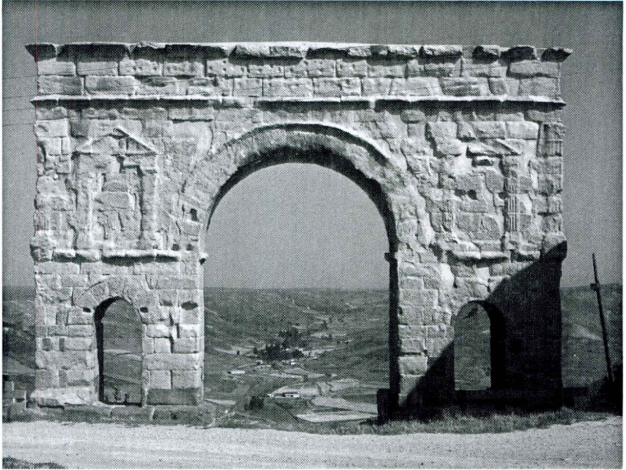
Figura 1: Arco de Medinaceli, fachada septentrional.
